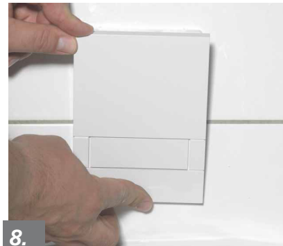
6. Exakt ausrichten und Kunststoff-Halterahmen auf Wandeinbaukasten aufschrauben.
