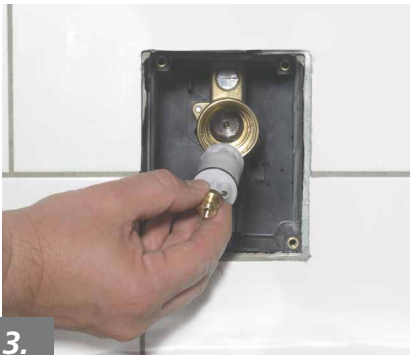
3. Weißen Blindstopfen entfernen. Kartusche einsetzen.
