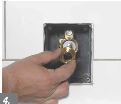
4. Überwurfmutter aufschrauben und anziehen!
